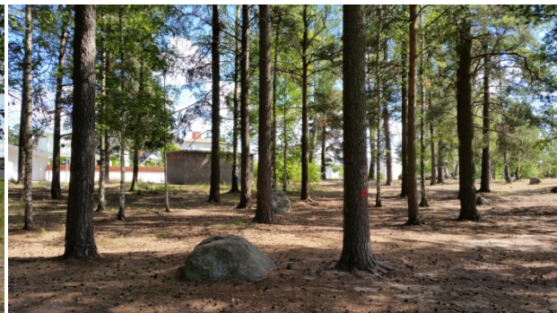
Transformatorstation i sydost
