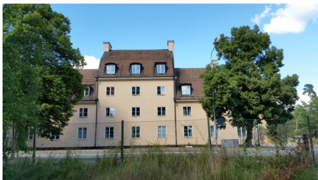
Högre bebyggelse norr om Oppundavägen.
