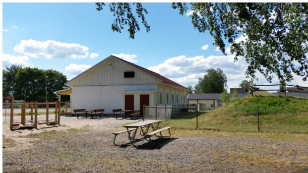
Skolbyggnad i södra delen av planområdet
